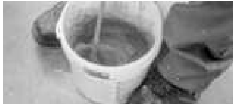
Prepare the grout | Prepara el material de rejuntado | Préparer le matériau de jointoiment | Rühren Sie das Fugenmaterial an
