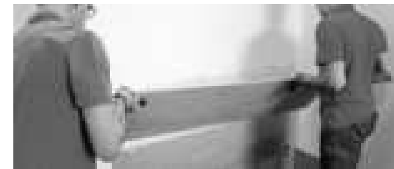
Affix the tile to the pre-prepared surface | Coloca la pieza sobre la superficie preparada | Placer la pièce sur la surface préparée | Verlegen Sie die Fliese auf der vorbereiteten Oberfläche
